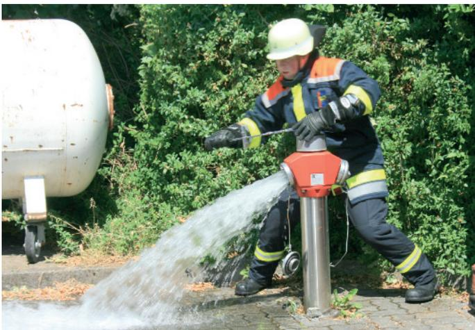
Der Hydrant wird vor der Wasserentnahme gespült
